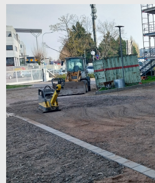
Rénovation du parking
